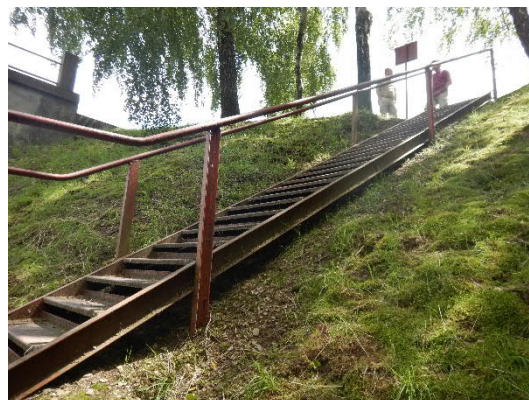
boční kotvení schodiště do terénu pomocí svislých U sloupků
