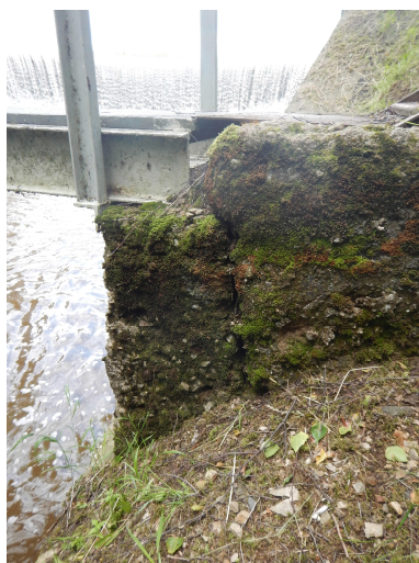
porušený levobřežní pilíř lávky – svislá trhlin a na celou výšku
