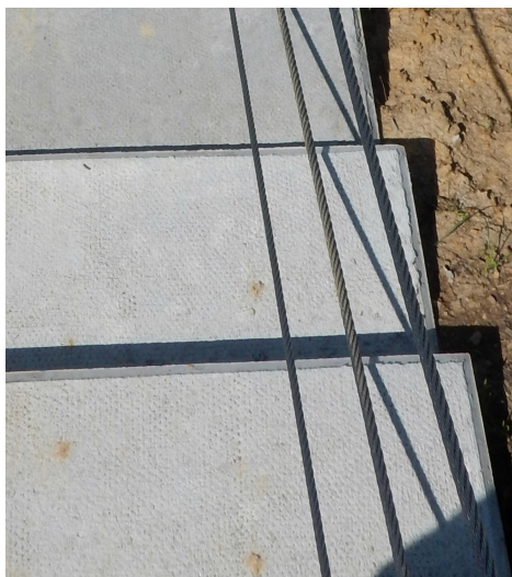
Požadovaný vzor zdrsnění a skosení stupňů
