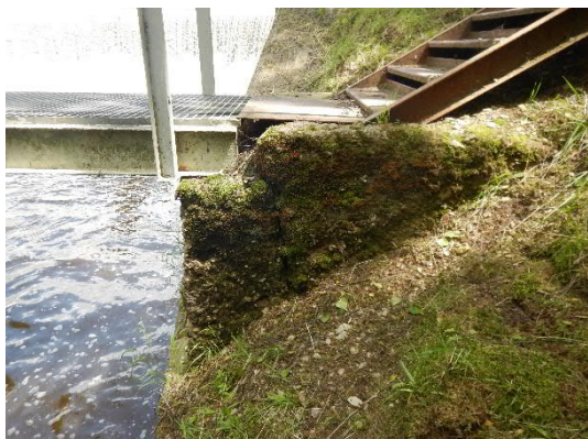
uložení spodní části na betonový blok
